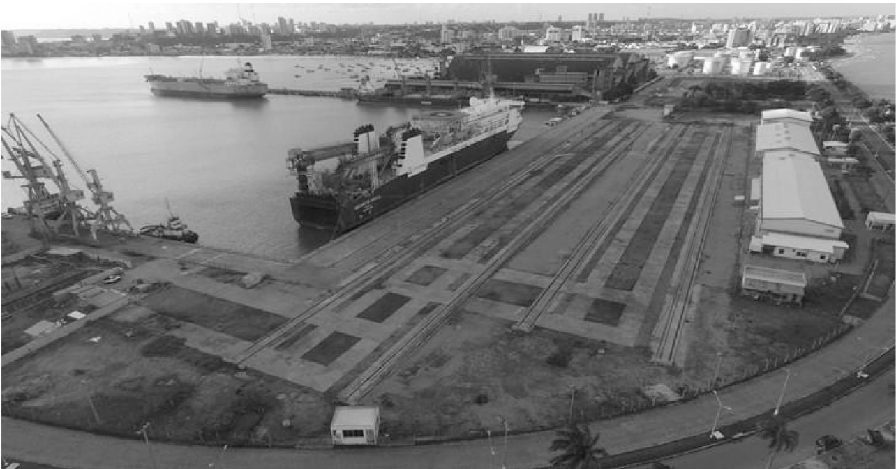
Figura 7: Cais do Terminal de cavaco do Porto de Maceió. Fonte: EVTEA Merco Shipping.
